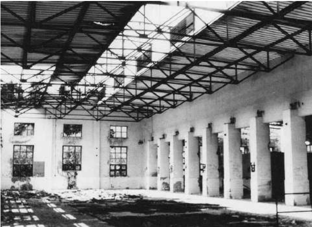
Interiér jižní haly kompresorovny s ocelovou příhradovou konstrukcí střechy, 1991 (zdroj: zanikleobce.cz, Norbert Weber)
