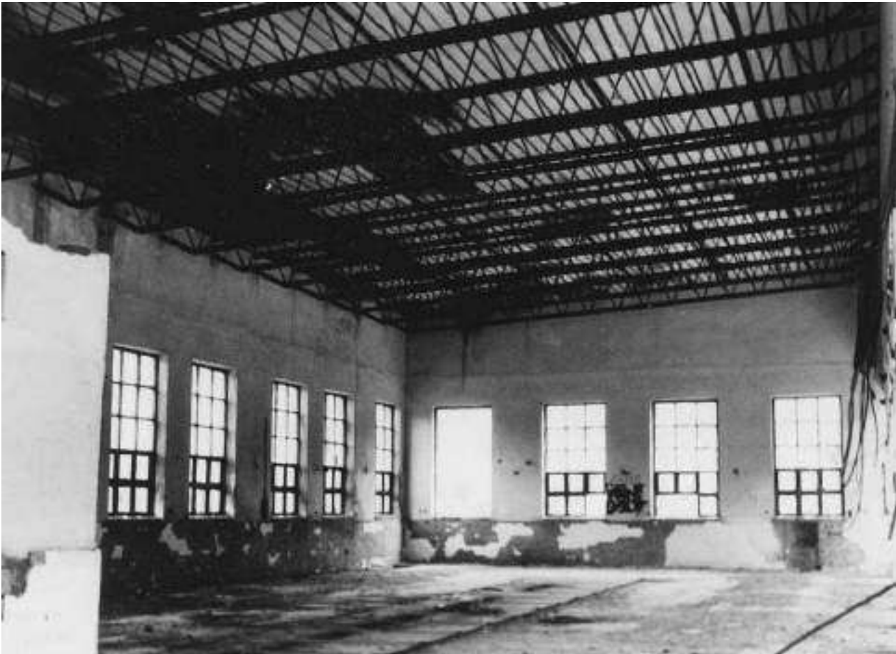
Interiér severní haly kompresorovny haly kompresorovny s ocelovou příhradovou konstrukcí střechy, 1991 (zdroj: zanikleobce.cz, Norbert Weber)
