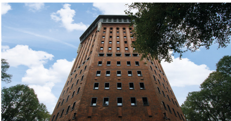
Obr. 11, 12 Hamburg-Sternschanze, Německo. Vyprázdněná obálka nadzemní části byla vyplněna racionální novostavbou hotelu ze železobetonu a oceli, foto: Jan Pustějovský
