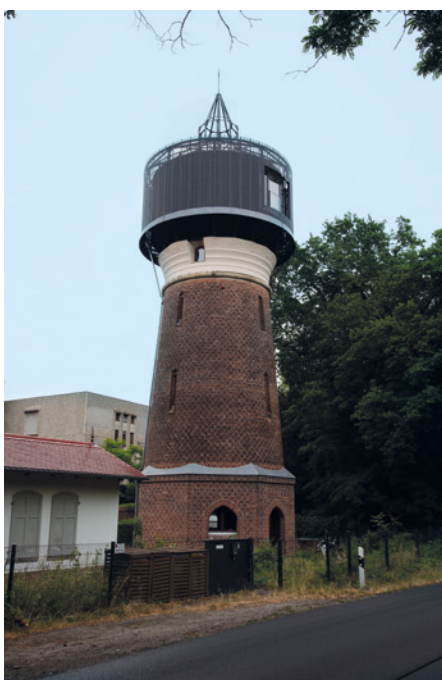
Obr. 9 Postupim, Německo. Přestavba vodojemu na rodinné bydlení, foto: Robert Kořínek
