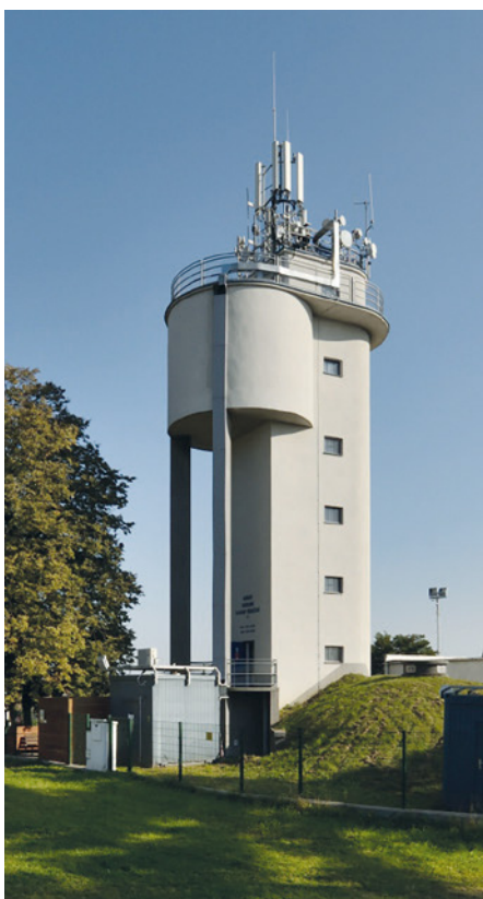
Obr. 3 Třebíč, architektura jako exponát – zpřístupněný vodojem je základem tematické expozice. Bonusem je vyhlídková platforma, foto: Robert Kořínek
