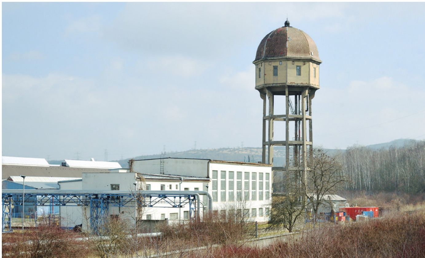
Obr. 1 Věžový vodojem v Bílině-Chuděřicích s křehkou železobetonovou skeletovou podnoží, foto: Robert Kořínek
