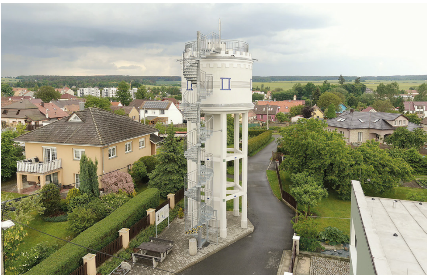
Obr. 2 Heřmanova Huť, jednoduchá přestavba vodojemu na rozhlednu s externím schodištěm a ochozem, foto: Robert Kořínek
