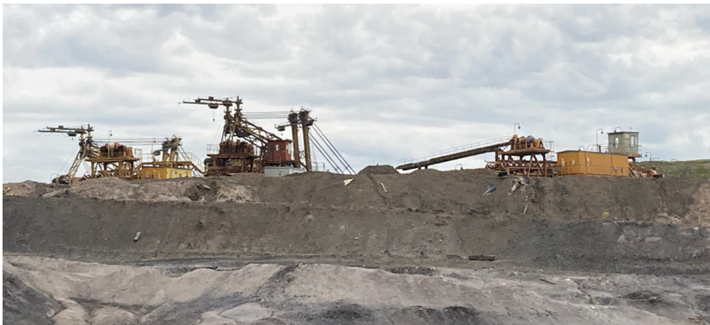
Obr. 2 Velkolom ČSA na Mostecku, pohled na těžební technologii, foto: Tomáš Šenberger
