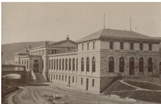
Obr. 2 Výpravní budova krátce po dokončení, zdroj: Státní okresní archiv Děčín
