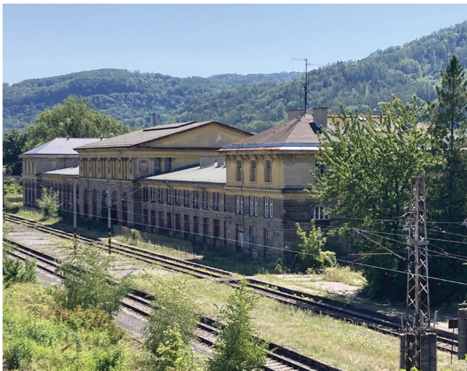
Obr. 8 Pohled z lávky přes kolejistiště, stávající stav, foto: Tomáš Šenberger
