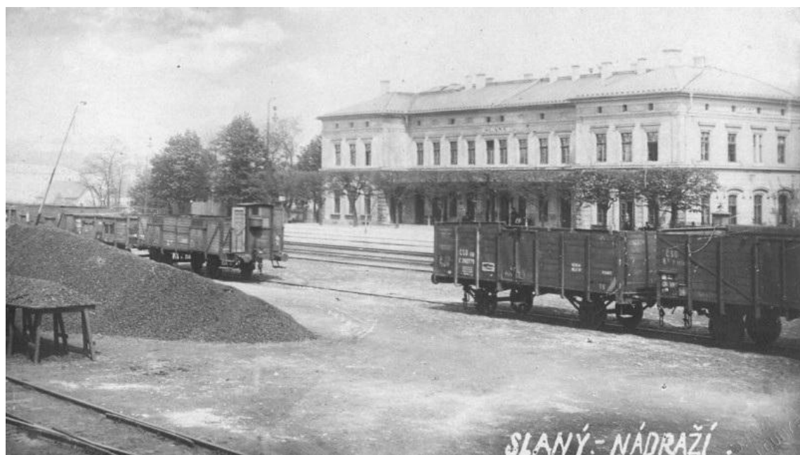
revitalizace výpravní budovy železniční stanice Slaný
