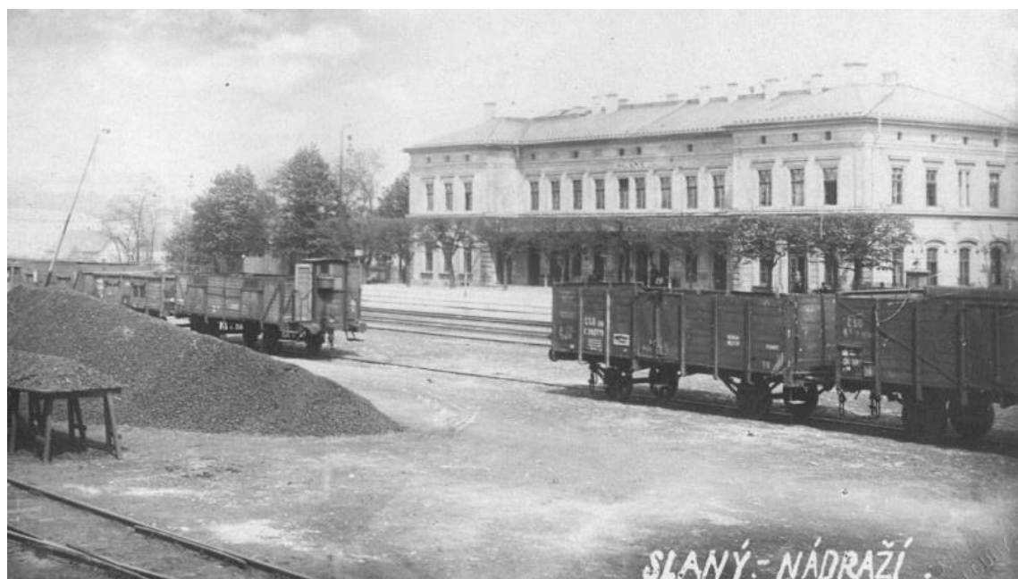
revitalizace výpravní budovy železniční stanice Slaný
