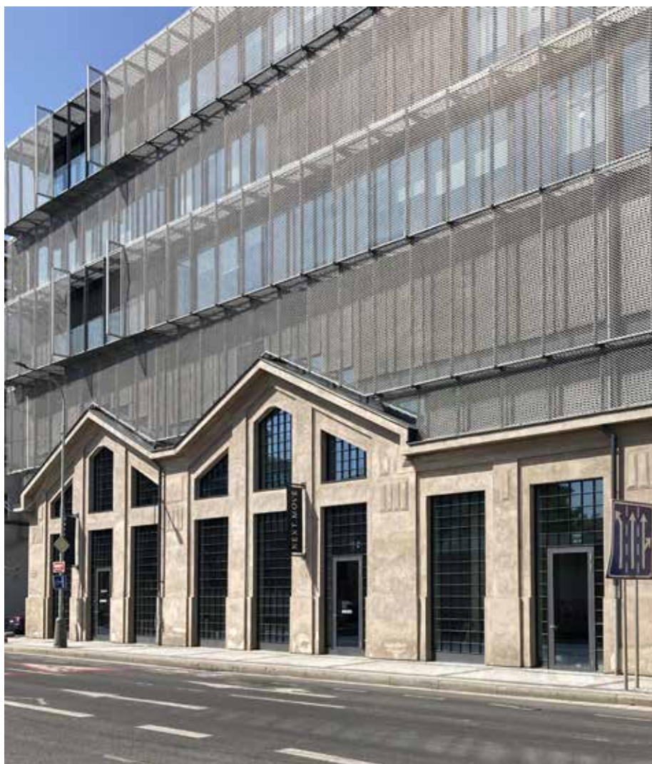
Obr. 6 Vozovna Smíchov – exteriér po adaptaci. Smíchovská vozovna z roku 1915, která sloužila pro tramvaje a později i pro trolejbusy, byla zbořena v souvislosti s výstavbou developerského projektu administrativní budovy FIVE (QARTA ARCHITEKTURA s.r.o., 2017). Jako připomínka předcházející historie, a tedy i jako příklad „destrukce“, byla zachována nárožní stěna původní haly, vestavěná do fasády šestipodlažní administrativy. Do interiéru vstupní haly byly zavěšeny repasované původní hodiny z průčelí vozovny.
