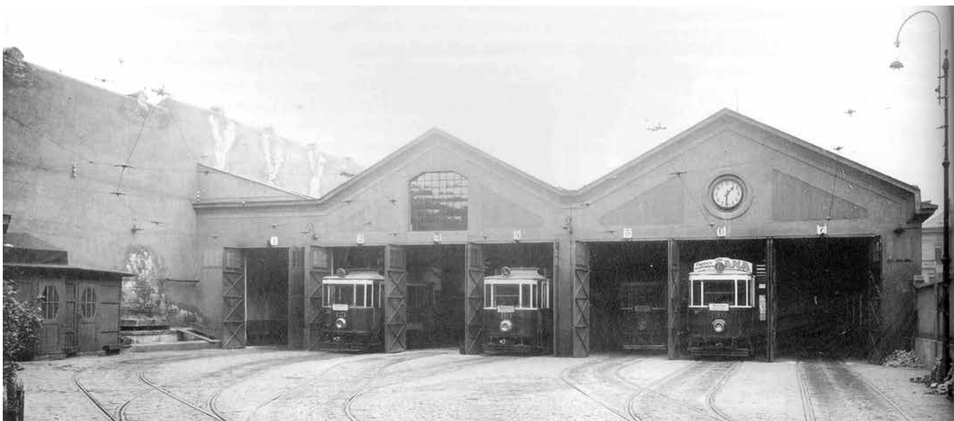
Obr. 5 Vozovna Smíchov, původní stav (foto: Archiv DP Hl. m. Prahy)
